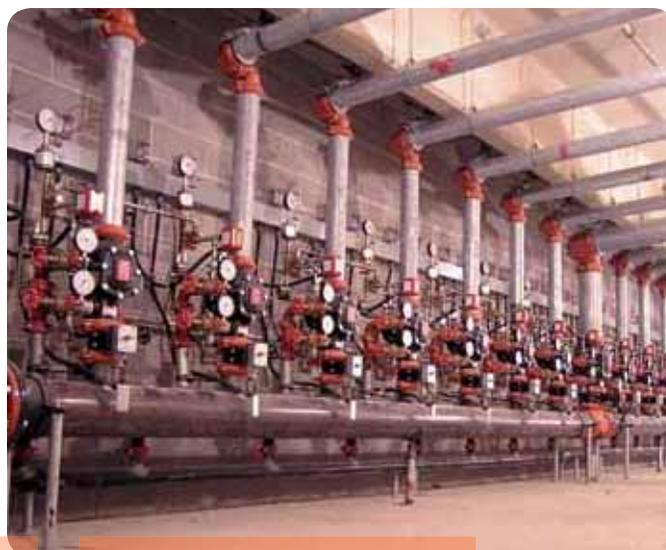
Válvula de retención FireLock NXT para sistema de red seca†
